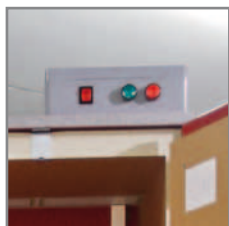
Unité de contrôle avec détection d'incendie
